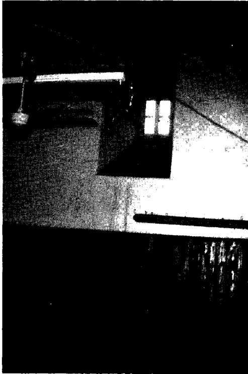
Resim: 10a- Güney duvar, doğu pencere
