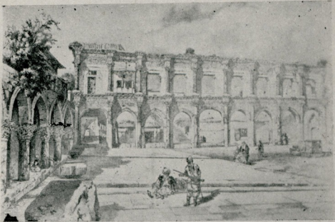
Diyarbakır Ulu camii avlusu
