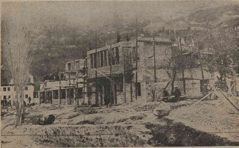
İnşasına faaliyetle devam edilen yeni Halkevi binası
